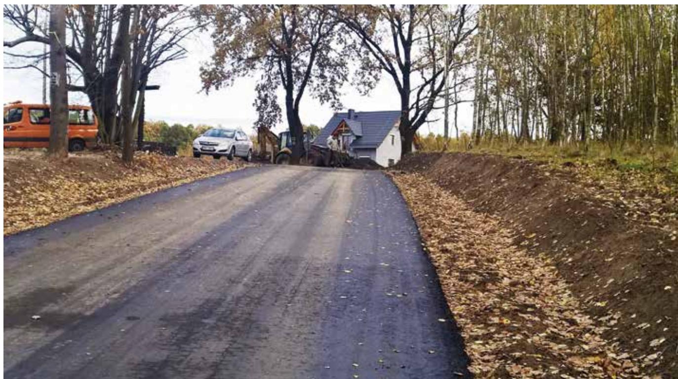
Wójt Gminy Radwanice odbiera promesę na dofinansowanie przebudowy drogi od wojewody dolnośląskiego Pawła Hreniaka.
