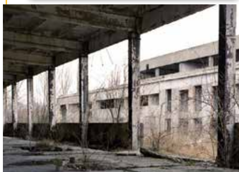
Teren dawnych Zakładów Lniarskich przed rozbiórką.
