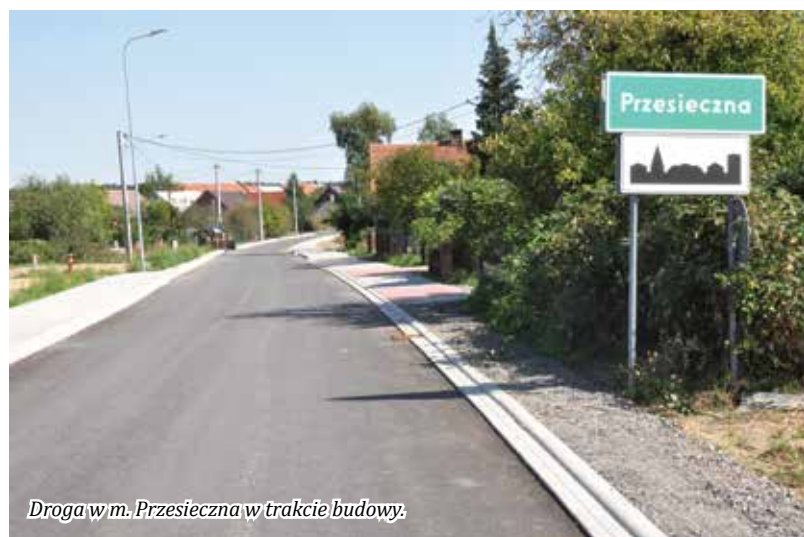
Droga w m. Przesieczna w trakcie budowy.
