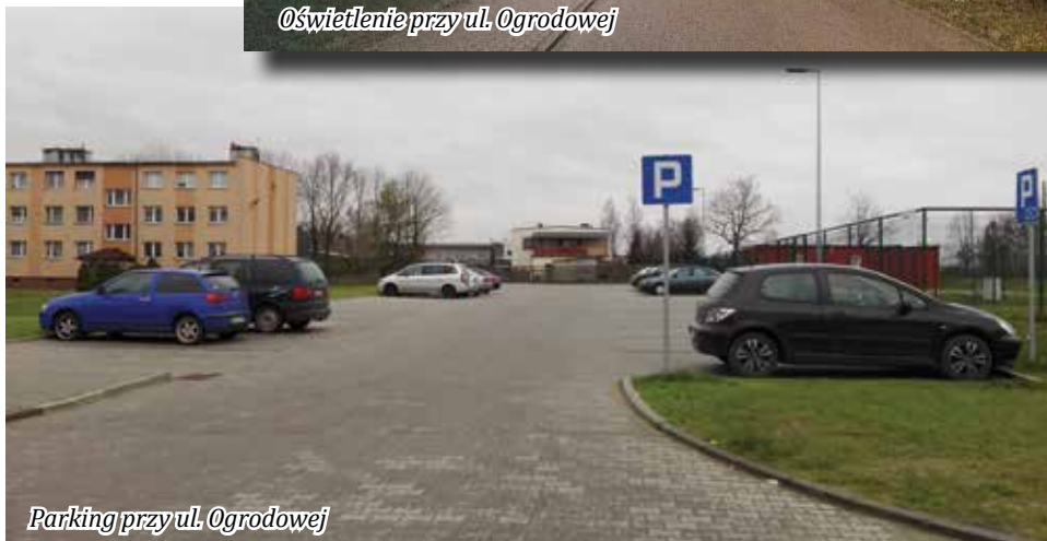
Oświetlenie przy ul. Ogrodowej
