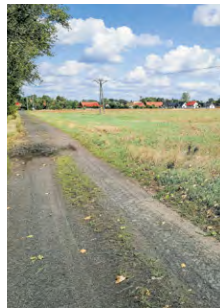
▲ Budowa sieci wodociągowej i kanalizacyjnej od ul. Włókienniczej.
