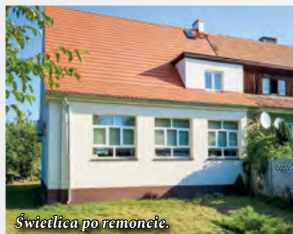
Świetlica po remoncie.
